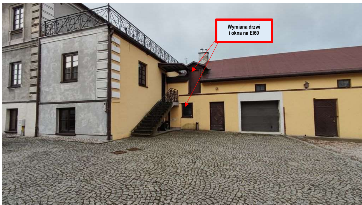
Rysunek 9 Wymiana okna i drzwi na EI60 w ścianie frontowej budynku PM "większego"
